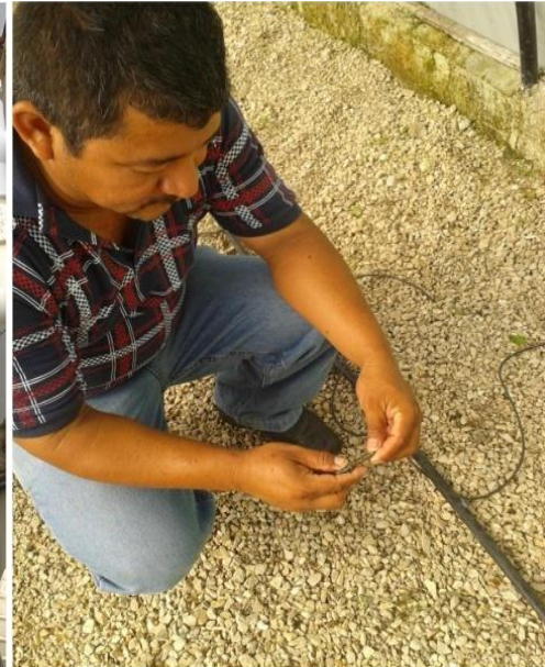
Figura 9: Instalación de goteros
