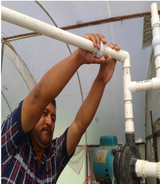
Figura 8: Instalaciones de tubería
