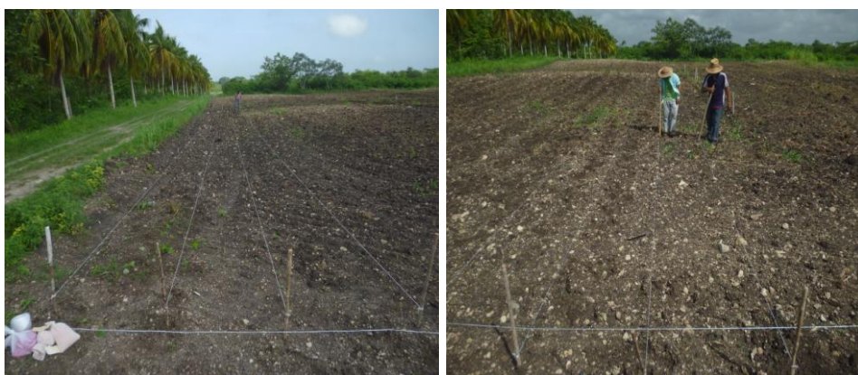
Figura 7. Colocación de Hilos
