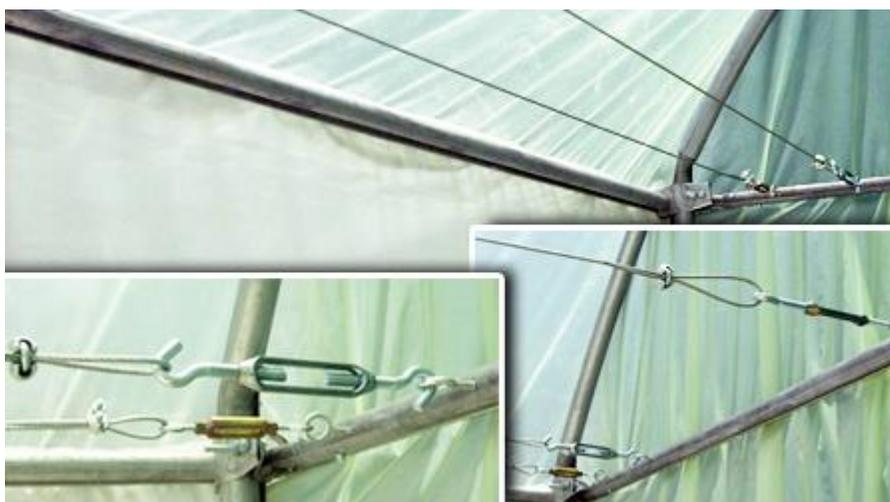
Figura 60.- Colocación del alambre galvanizado
