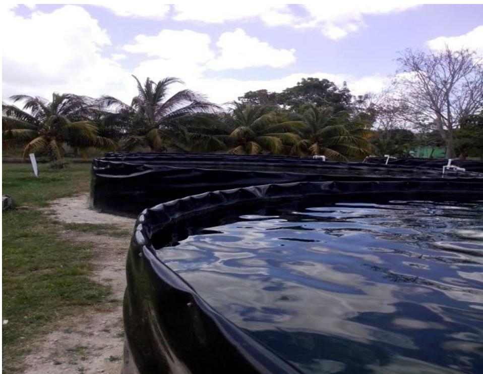
**Figura 4. Estanques de Geomembrana para la cría y engorda de Tilapia.**
